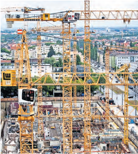
Großbaustelle Leopoldstraße: Hier entsteht das „Schwabinger Tor“. FOTO: PELJAK
