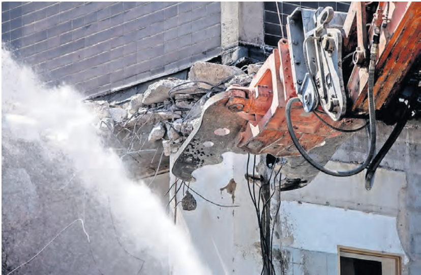
Ein Greifarm bricht die Brocken aus der Fassade und trägt die Gebäude Stück für Stück ab. Insgesamt 100 000 Tonnen Stahlbeton müssen am Vogelweideplatz weggeräumt werden.
